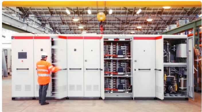
Proceso de fabricación del convertidor
