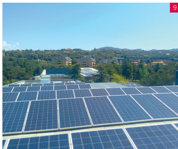
8. Instalación de autoconsumo residencial GUIPÚZCOA. PAÍS VASCO (ESPAÑA) 3,3 kW 1 INGECON® SUN 1Play 1 INGECON® SUN EMS Board
